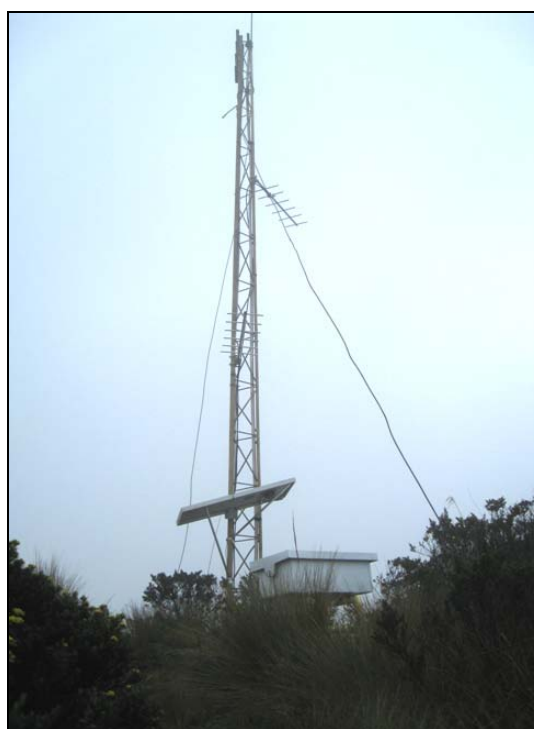
Figura 3. Estación repetidora RECREO.
