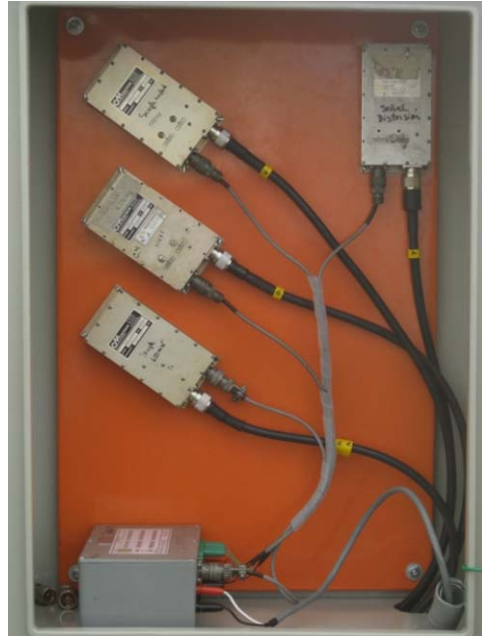
Figura 64. Estación repetidora de CIELO ROTO después de trabajos realizados
