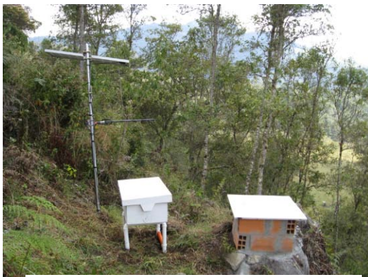
Figura 68. Estación de inclinometría electrónica de RODEO.
