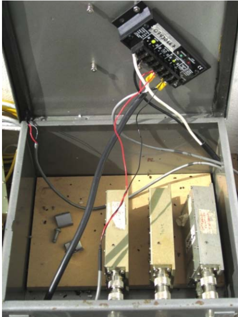
Figura 63. Estación repetidora de CIELO ROTO antes de trabajos en la estación
