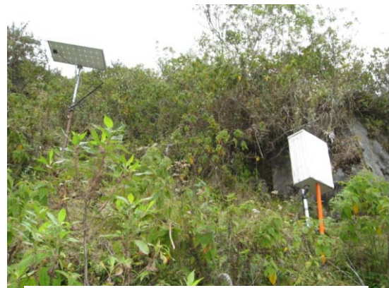
Figura 69. Estación de inclinometría electrónica de LAGUNA.
